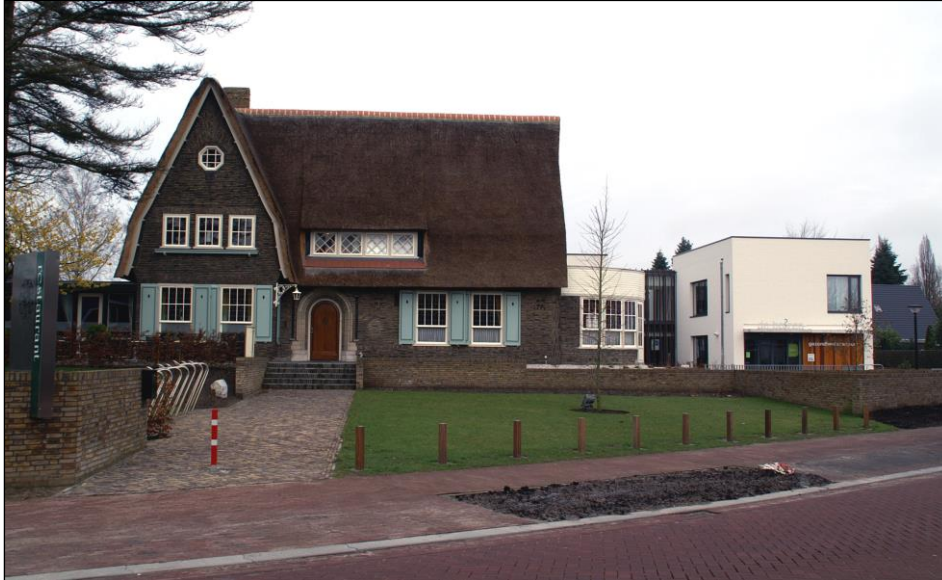
Afbeelding Rijksmonument villa Het Slot, Kruisstraat 23, bij de voltooiing van de restauratie in 2011. Rechts het entreegebouw van De Bolzen. (foto: Ton Bolsius, SHEV)
